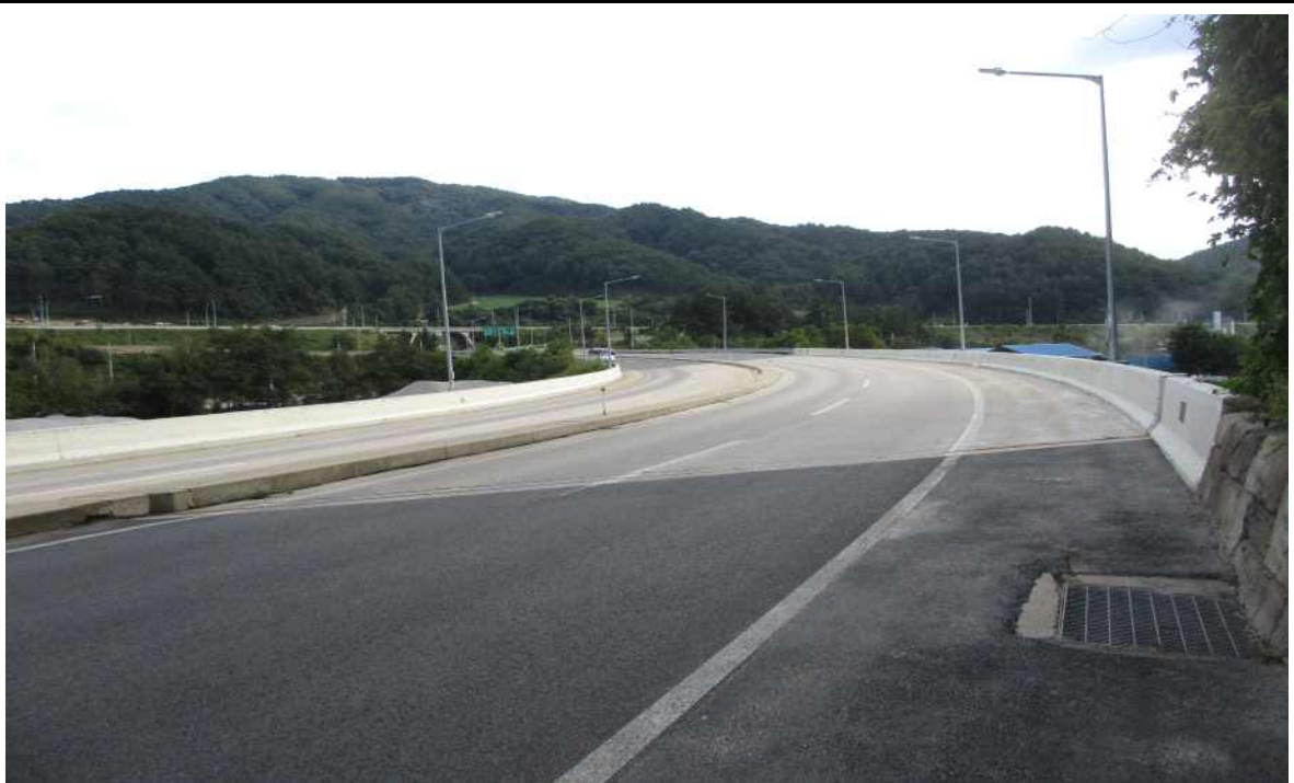
교량 상부 전경
