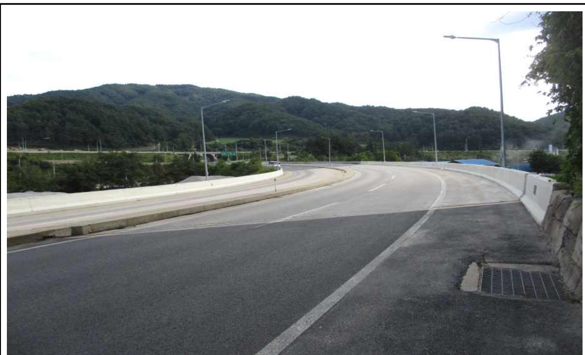
교량 상부 전경
